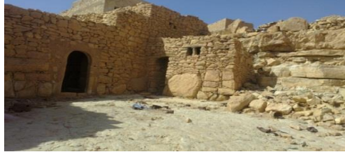
الصورة رقم (4) نوافذ التهوية في المباني قديماً بالمدينة
